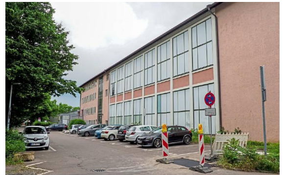
Unter der Reihe von Parkplätzen im Dragonergässle (Schulviertel Innenstadt) will die Stadt in diesem Sommer einen unterirdischen Speicher für Regenwasser anlegen. Foto: Holm Wolschendorf
