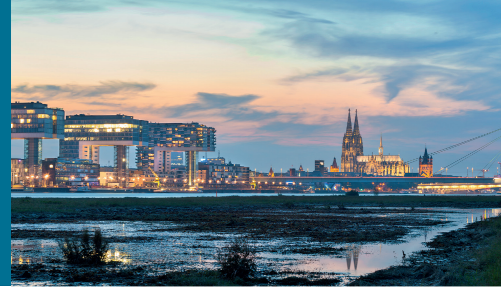
In Köln, der Metropole im Spannungsfeld zwischen Tradition und Moderne, ist das Thema Hochwasserschutz stets aktuell. Im Vordergrund Überschwemmungsflächen am Rheinufer.
